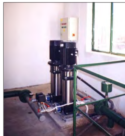
Sistemul de alimentare cu apă a fost reabilitat
