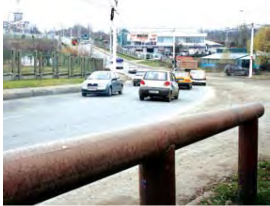
TICO s-a înfipt într-un parapet construit din niște țevi groase.
