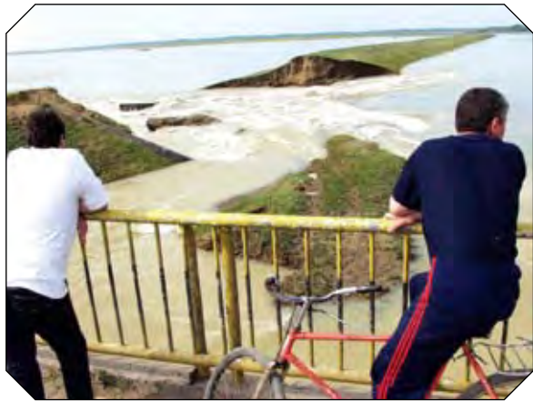
Breșa din digul de la Piscu
