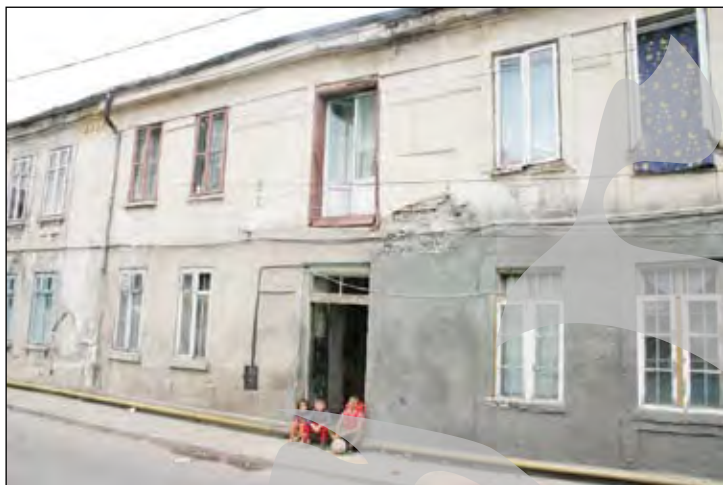
Cuza nr. 23- Trei călare pe conducta de sub prag
