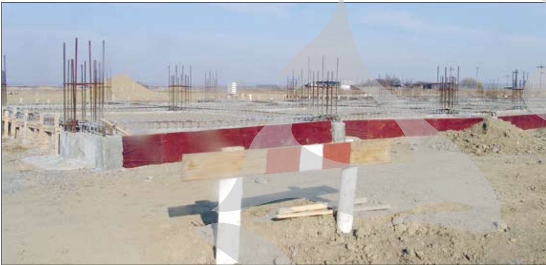
Fundația sediului administrativ al viitorului Parc Industrial
