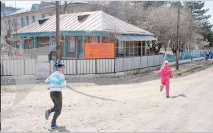
Sediul PD are vedere la stradă
