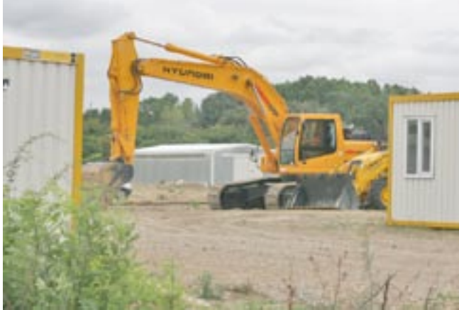
Firma turcească are experiență în construcția stațiilor de epurare
