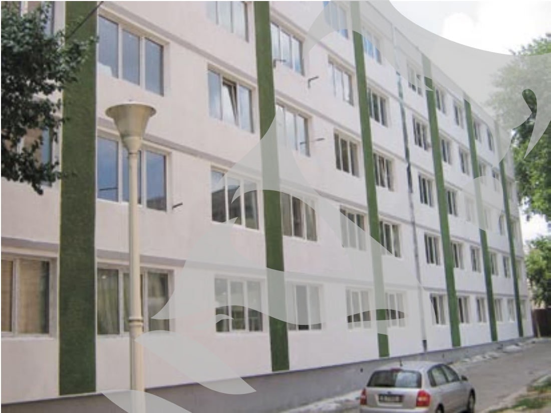
Așa arată căminul G, primul căruia i s-a renovat fațada
