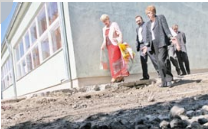
Pe locul pe unde calcă inspectoarea generală Tania Bogdan (stânga), apa și mărul au fost de jumătate de metru
