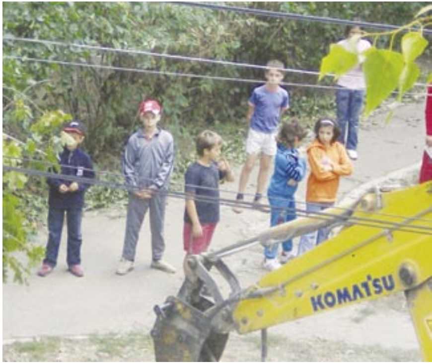
Tiananmen românesc - îngroziți, copiii au încercat până la sfârșit să împiedice distrugerea vechiului loc de joacă
