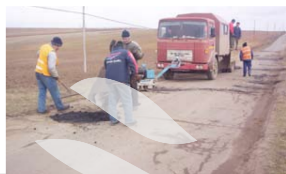
Drumari de la Tg.Bujor, în nordul județului, înainte de Paști, la plombat gropile din asfalt
