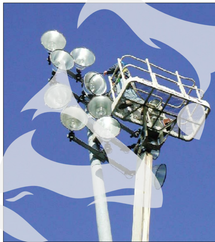
Exact două săptămâni mai sunt până la începerea lucrărilor de montare a instalației de nocturnă pe Stadionul „Oțelul”
