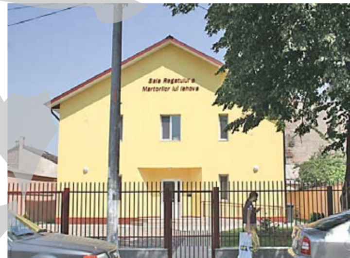
Pe strada Eroilor, între Casa Armatei și Farmacia Ținc a răsărit o clădire din cu totul alt film
