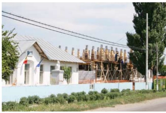
La Cuza Vodă crește văzând cu ochii o minunăție de școală. "La anul o vom da în folosință", spune primarul Dănuț Codrescu
