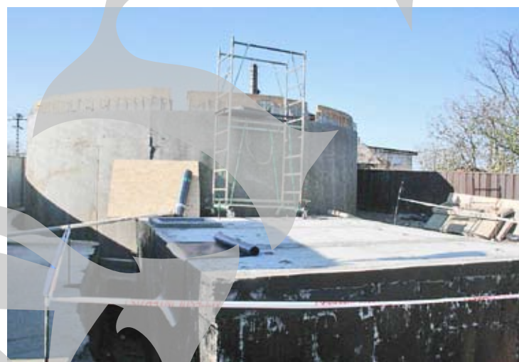
Gospodăria de apă este aproape gata
