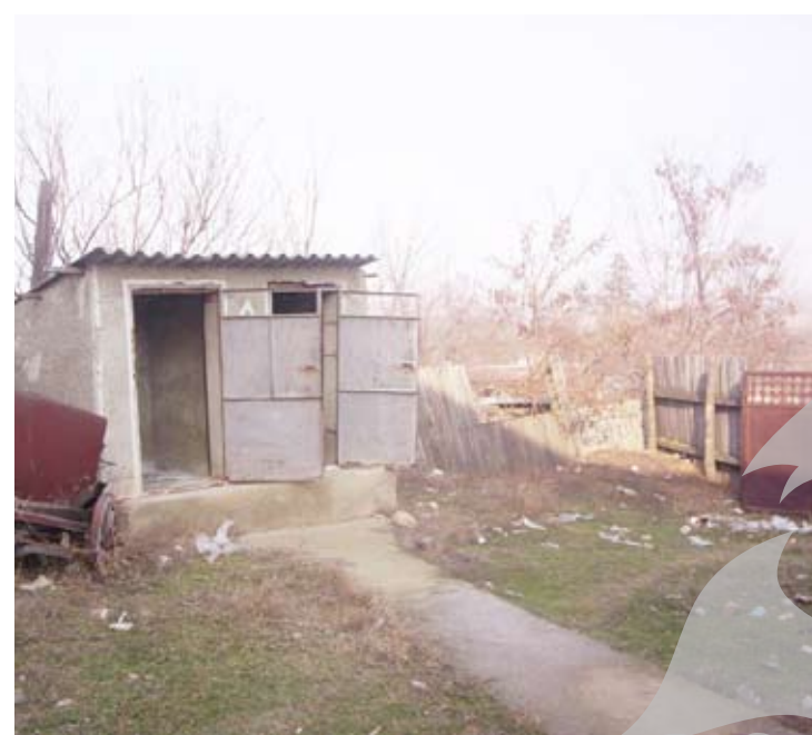
Fostul closet al primăriei
