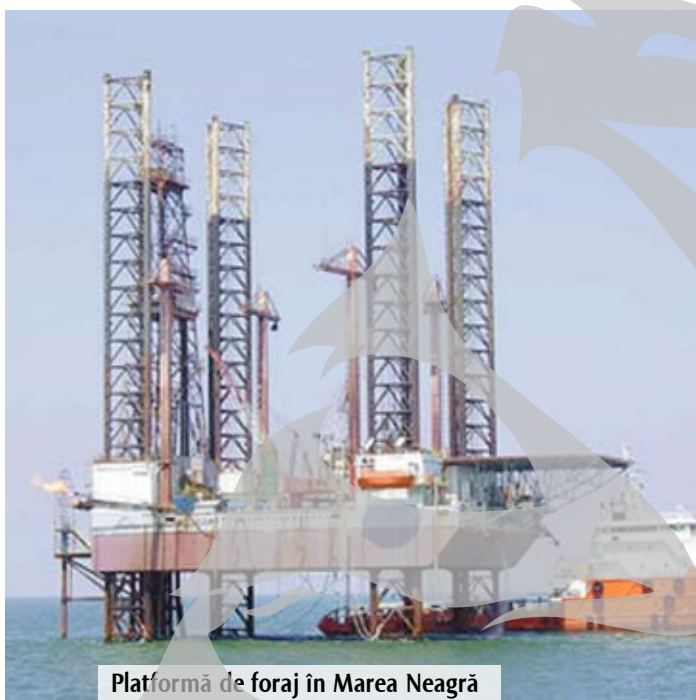
Platformă de foraj în Marea Neagră
