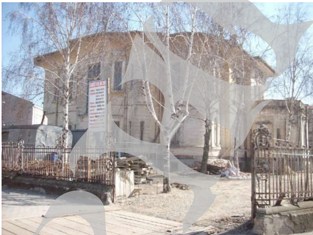
Casa Nicăpetre, în plină restaurare pe bani europeni
