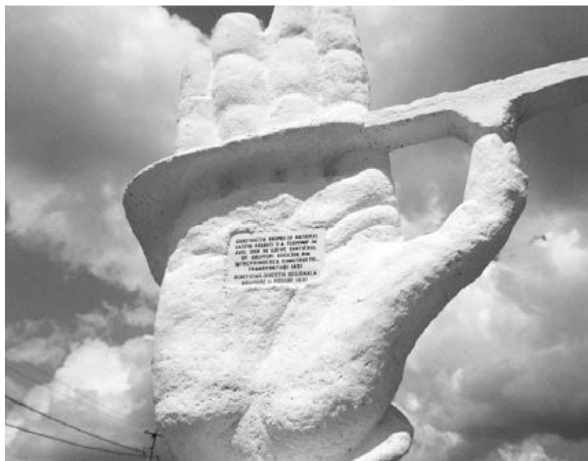
Construcție pe drumul național Sadova-Rădăuți
