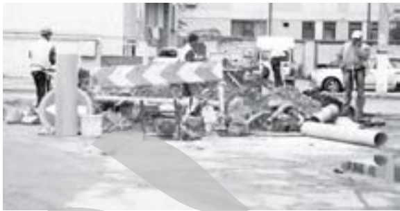
Multe din străzile Galațiului s-au transformat în șantiere
