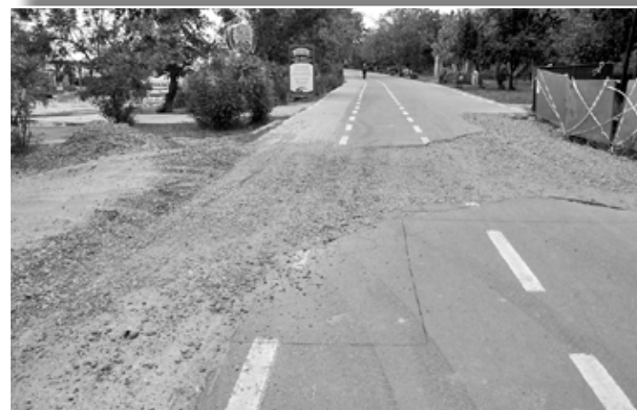
Pe Faleză Inferioară, pista nu mai are guri de canalizare, ci simple șanțuri
