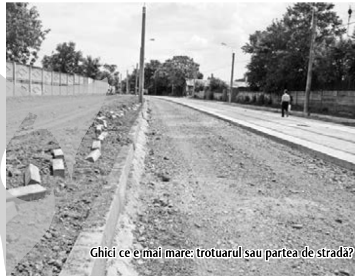
Stradă cât vezi cu ochii. În față, nu în laterale
