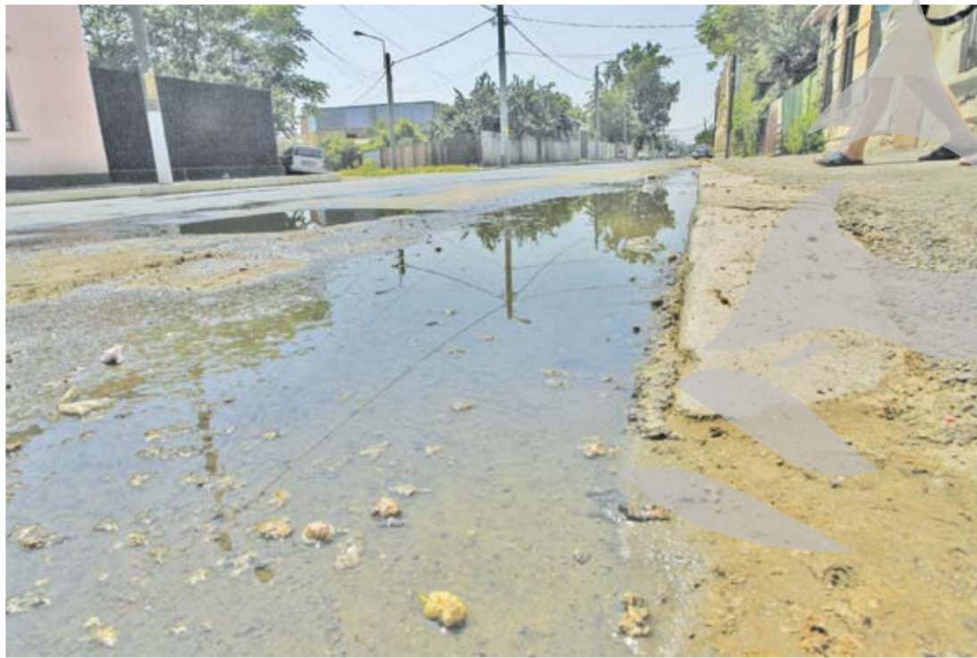
Din cauză că apa curge neîntrerupt de două săptămâni, după ce țeava din subteran s-a spart, în carosabil au apărut așa-numitele "burți"
