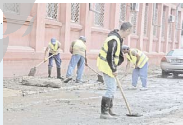
Muncitorii Ecosal curăță zonele afectate de inundații
