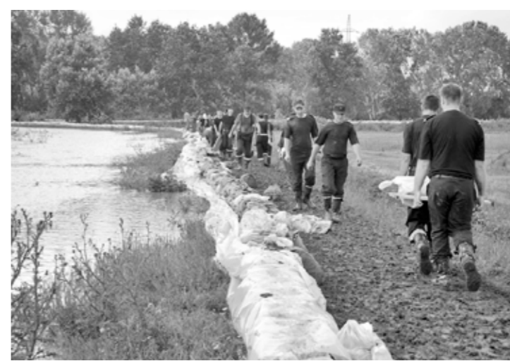
Lucrătorii ISU au lucrat contracronometru la suprînălțarea digului
