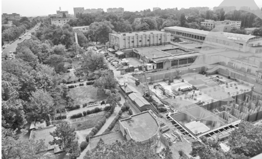
Șantierul, văzut de sus
