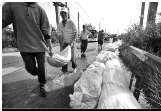
Se lucrează la dig
