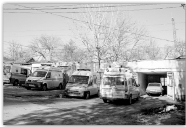
Garajele pentru autosanitare de la Târgu Bujor vor fi demolate și, în locul lor, va fi construit un sediu nou pentru Stația de Ambulanță
