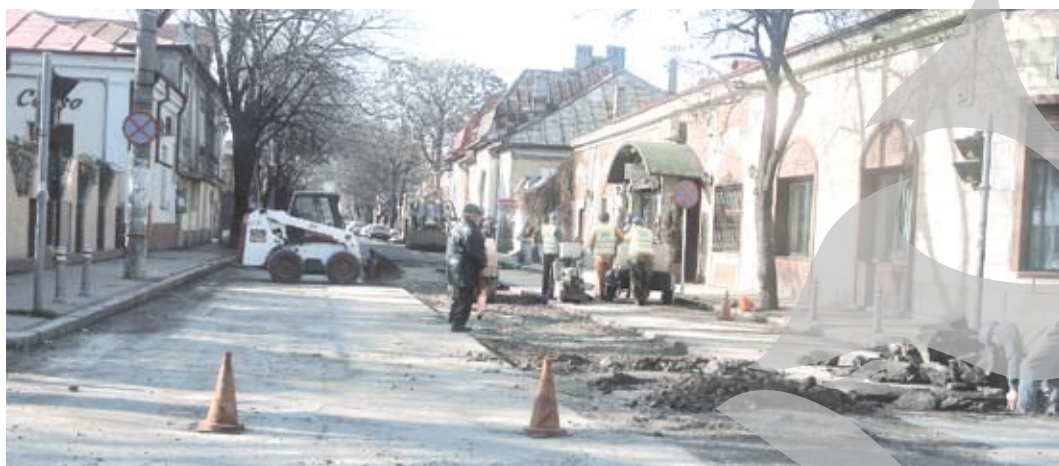
Așa arată vineri strada Gării, pregătită fiind pentru asfaltare...
