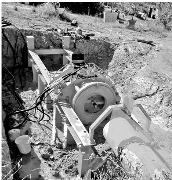
Așa arată un utilaj care execută lucrări de foraj orizontal
