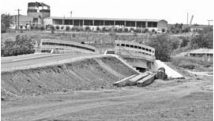
Unul din podurile construite recent
