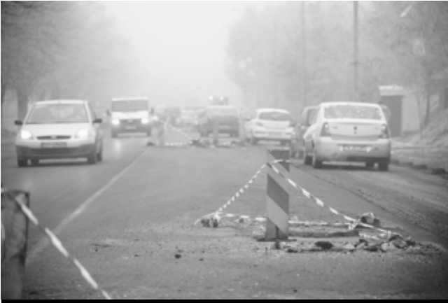
Asfaltare de iarnă pe Faleză
