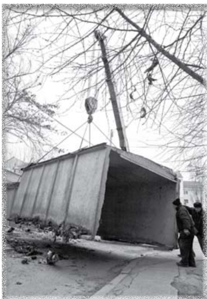
Demolarea garajelor s-a făcut doar de paradă. Pariază cineva pe anul electoral 2012
