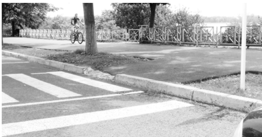
Rampă de formă pe strada Marii Uniri
