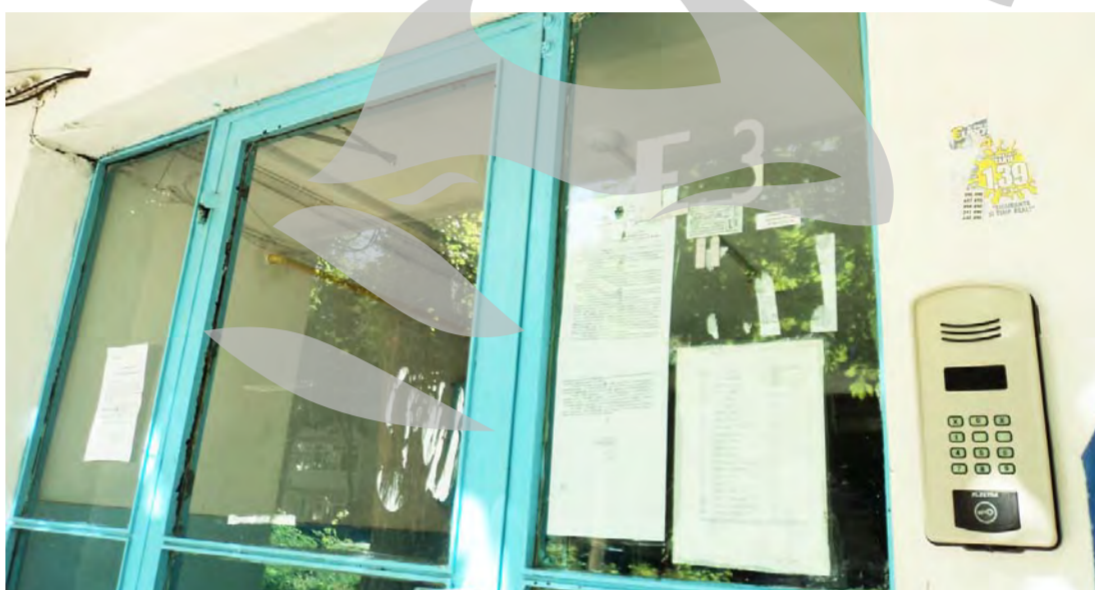
Blocul E 3, unul dintre cele trei imobile care nu primește apă caldă din cauza datoriilor asociației
