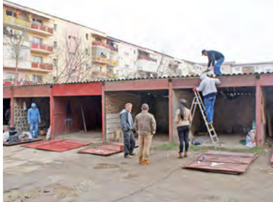
Garajele construite ilegal pe domeniul public erau demolate vineri, într-un cartier din Satu Mare
