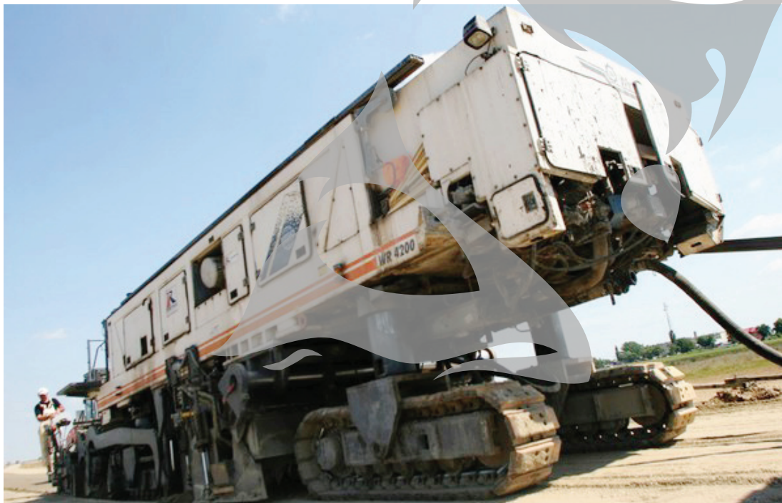
Tren de reciclare in situ
