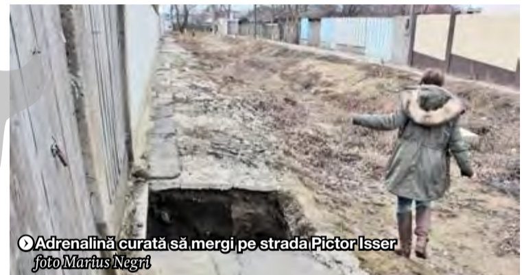
► Șantier în lucru abandonat foto Marius Negri
