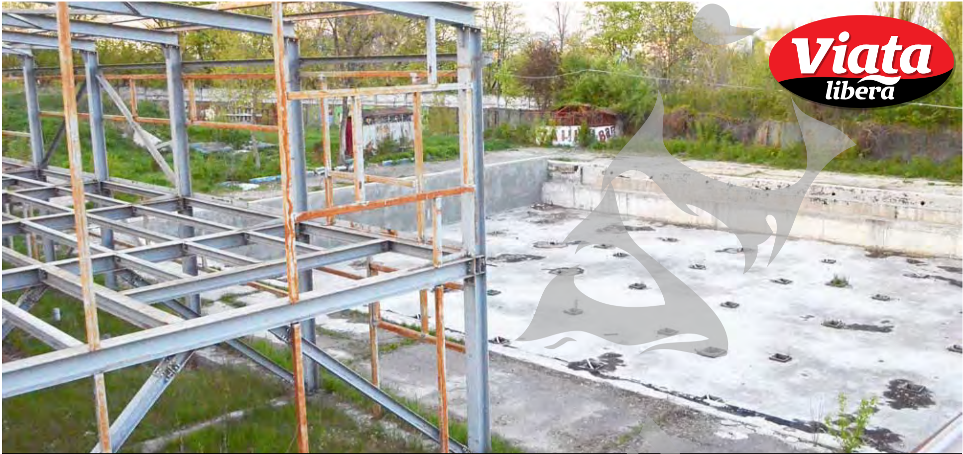
Doar structura metalică, a ceea ce se vrea a fi anexa administrativă și vestiare, a apucat să se facă în 2011 foto Sonia Baciu
