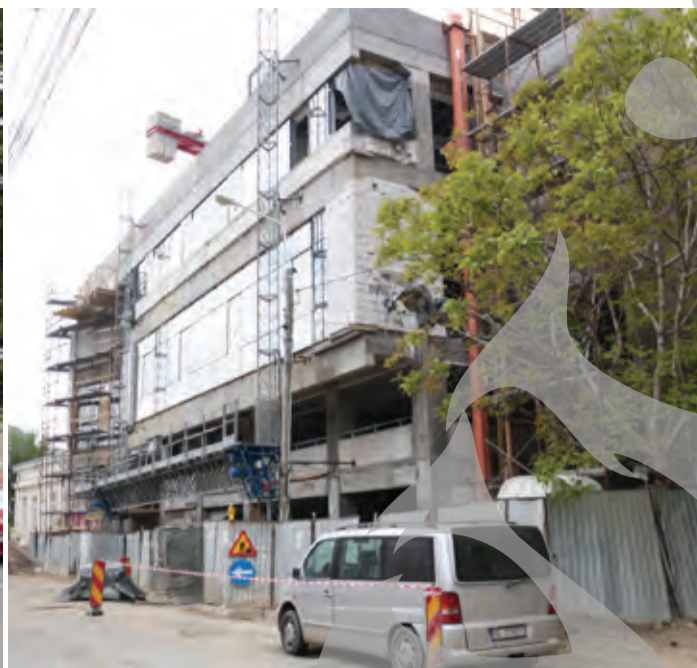
De pe strada Cuza, clădirea pare departe de finalizare
