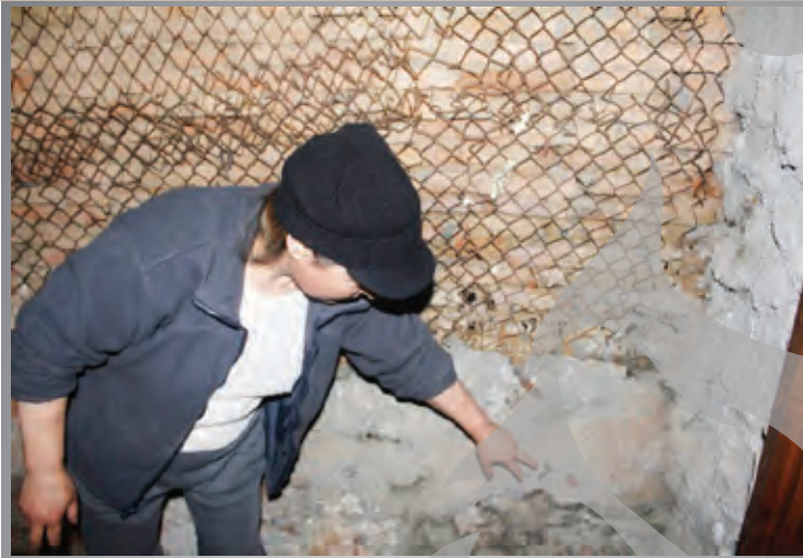
► Din cauza umezelii, tencuiala se macină și au crescut ciuperci pe peretele bucătăriei foto Marius Prisacariu
