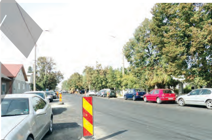
► Pe strada Traian lucrările se apropie de final
