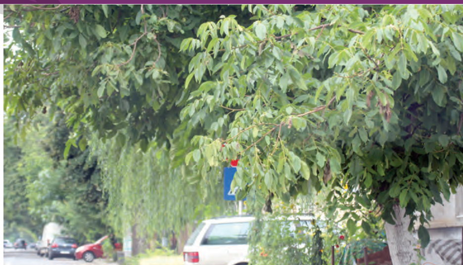
➤ STOP-ul este vizibil abia atunci când te apropii de intersecție, așadar, circulați cu mare atenție!
