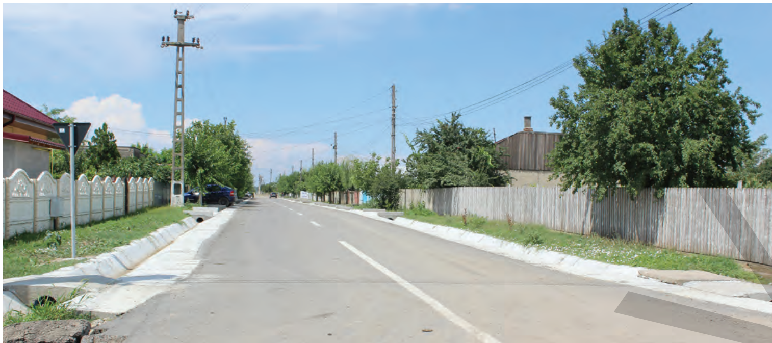
● Străzile asfaltate au rigole și podețe pentru ca fiecare localnic să aibă acces în curtea sa foto Iulia Kelt
