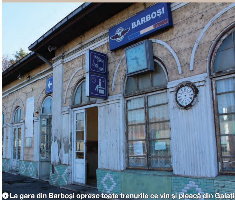
● Clădirea gării are crăpături în pereți și uși din lemn, fără sticlă
