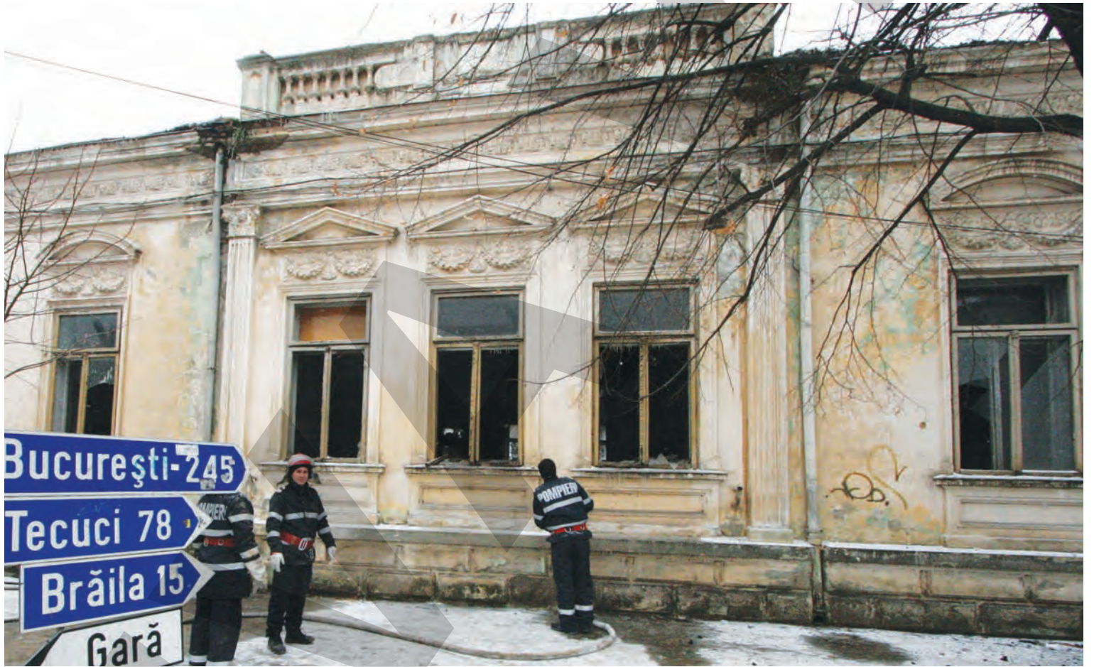
● Lucrările de restaurare a clădirii au fost marcate de un incendiu foto arhiva VL
