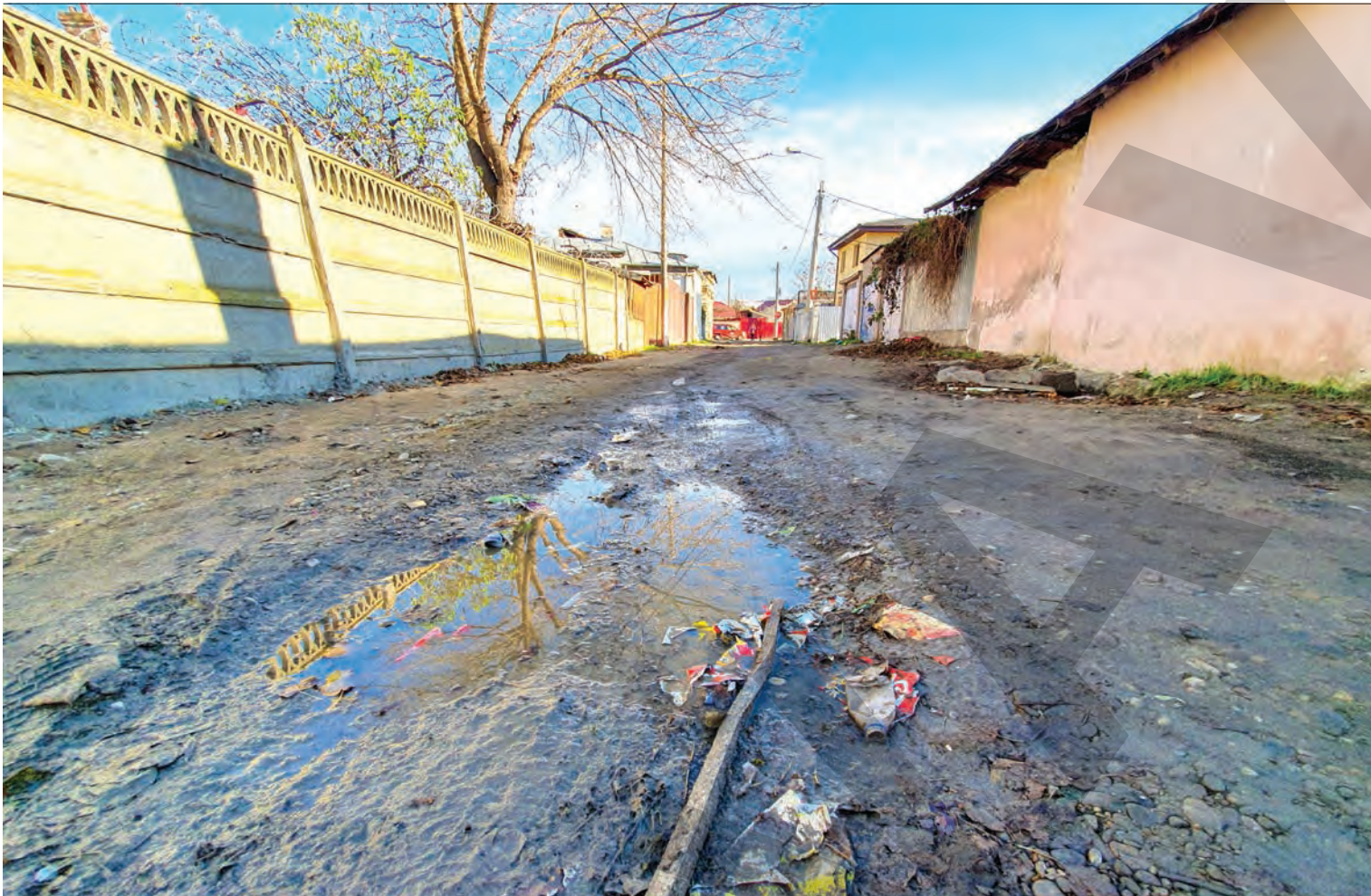
● Strada Plevnei, în plină modernizare foto Bogdan Codrescu
