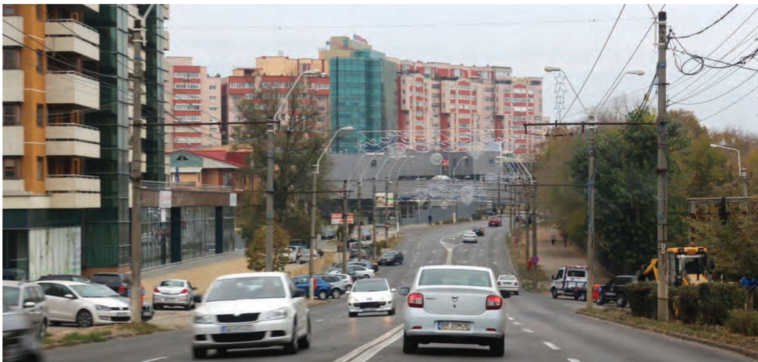
● Două dintre benzinăriile dezafectate se află pe strada Brăilei
