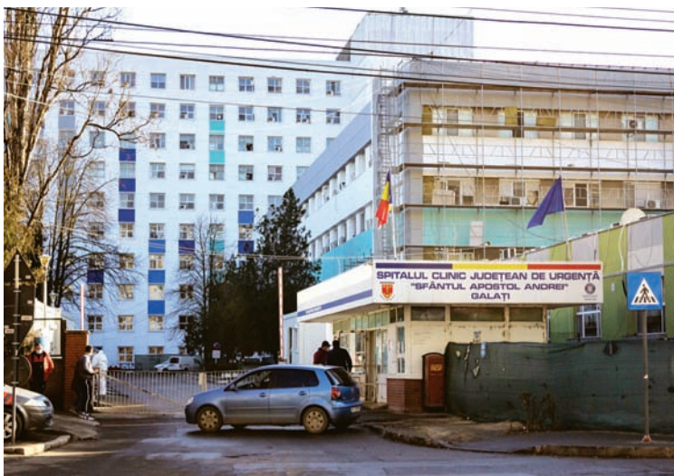
Clădirea spitalului, înainte de aplicarea plăcilor de compozit
