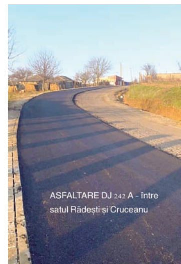
ASFALTARE DJ 242 A - între satul Rădești și Cruceanu deja primul strat de asfalt pe un sens de mers, de la intersecția cu DN 24D și până la ieșire din satul Rădești către Cruceanu, urmând a fi asfaltat și celălalt sens. ●
