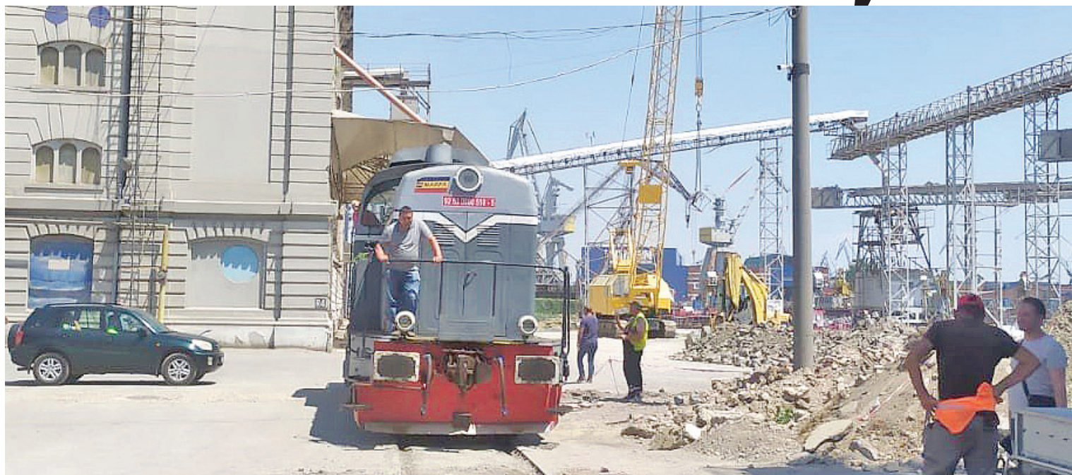
sursa foto: CFR Infrastructură
